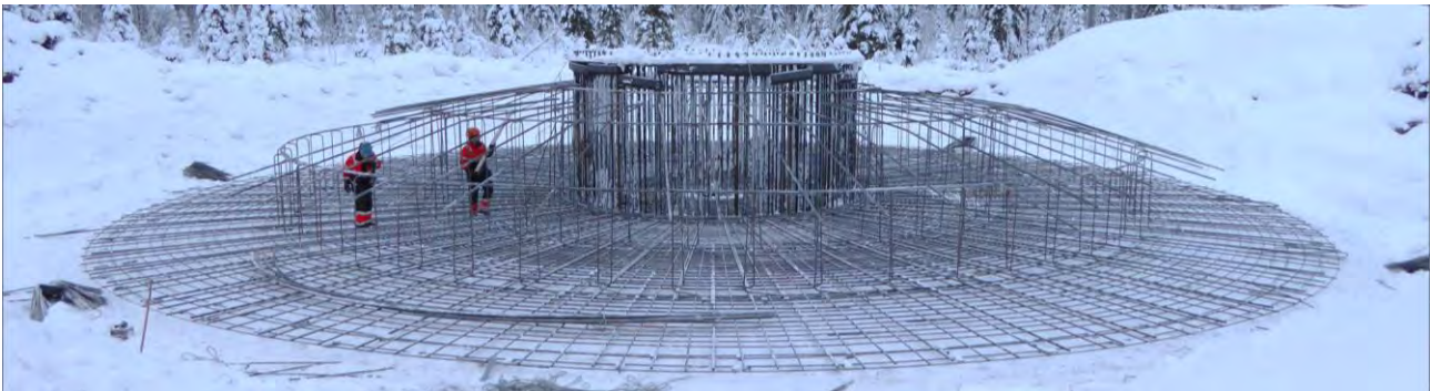
Kuva 1: Tuulivoimalan perustuksen raudoitus
